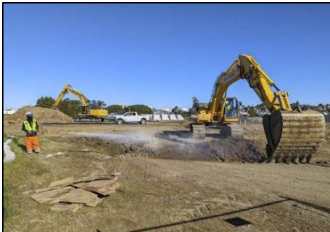
Trabajadores excavando suelos contaminados mientras rocían agua para controlar el polvo.
