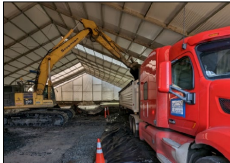
La tierra excavada se carga en un camión para su eliminación fuera del sitio.
