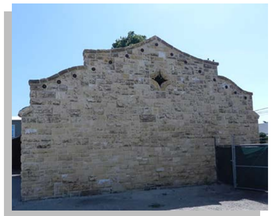
PG&E readecó el antiguo edificio de gas, que se muestra arriba, y permanecerá en el sitio.
