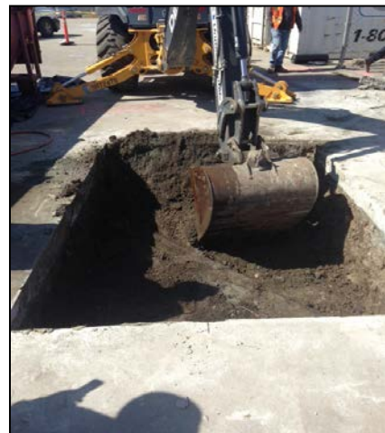
Los trabajadores excavarán pequeños agujeros para observar las condiciones subterráneas
