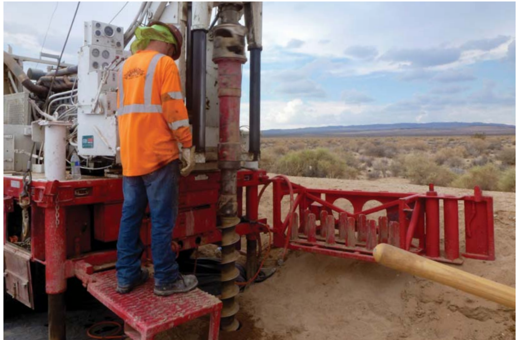
El año pasado, las cuadrillas instalaron pozos adicionales de monitoreo de las aguas subterráneas como parte del estudio de antecedentes actualizado de cromo 6.
