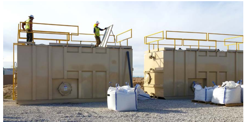
Los obreros preparan los tanques de 10,500 galones para la prueba piloto.
