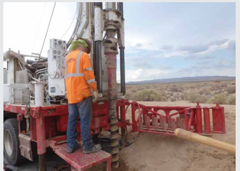
Los obreros instalarán pozos de monitoreo de aguas subterráneas adicionales como parte de la actualización del estudio de antecedentes de cromo 6.
