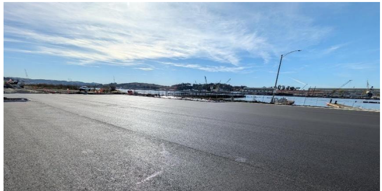
Nueva pavimentación en la zona del estacionamiento del embarcadero.
