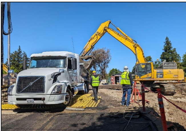
La tierra excavada se cargó en camiones para su transporte a un vertedero autorizado.
