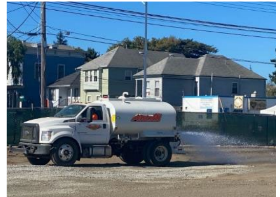
El suelo se mantendrá húmedo para ayudar a controlar el polvo y los olores.
